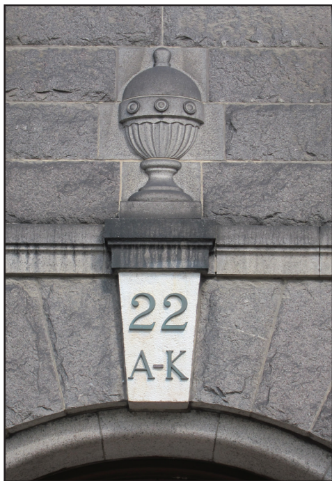
Slutsten i hvid marmor over porten mod Hørsholmsgade. Foto: KSJ, maj 2018.
